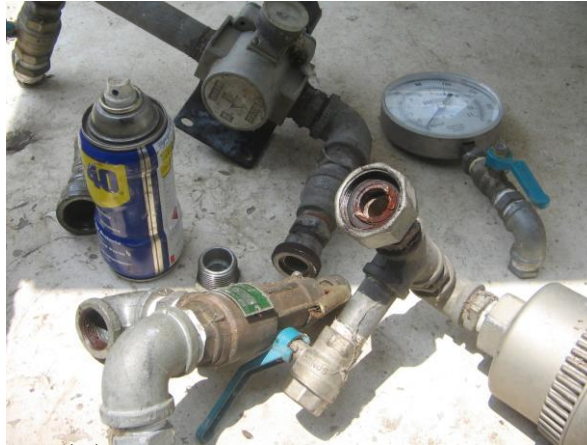
ถอดอุปกรณ์ที่เกี่ยวข้อง ของ Air receiver tank ก่อนทำ Hydrostatic Test
