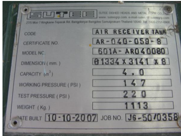
Nameplate ระบุ ของ Air receiver tank
