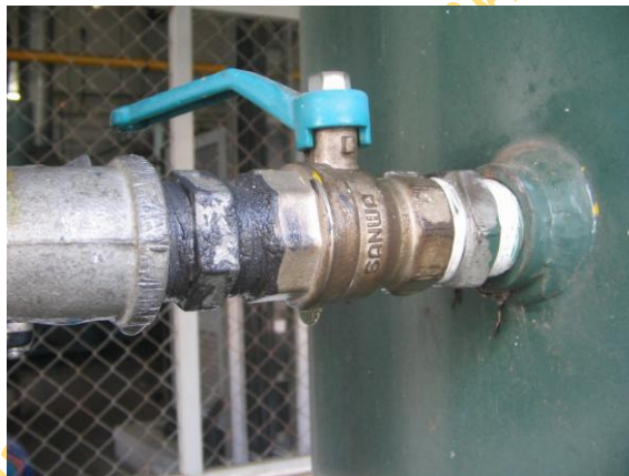
การใช้งาน Valve ที่ไม่ถูกลักษณะงาน รับแรงดัน
